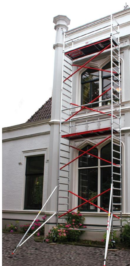
Se o espaço disponível para a colocação da torre de andaime for reduzido, a Torre Rolante Altrex 5100 oferece-lhe a solução ideal, em virtude dos bastidores possuírem apenas uma largura de 75 cm.
